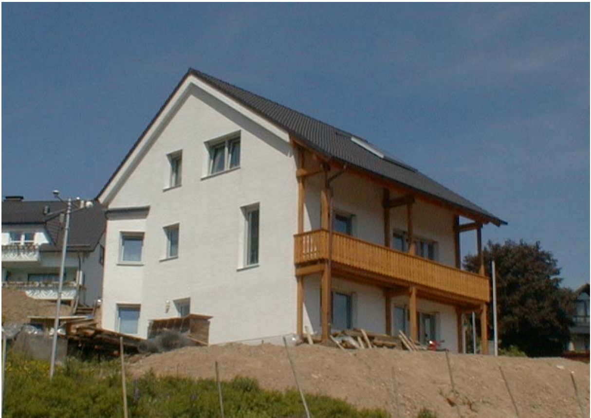
Ansicht des Hauses von Südwesten
