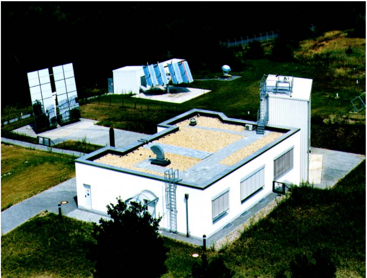
Ansicht des Laborgebäudes von Südwesten
