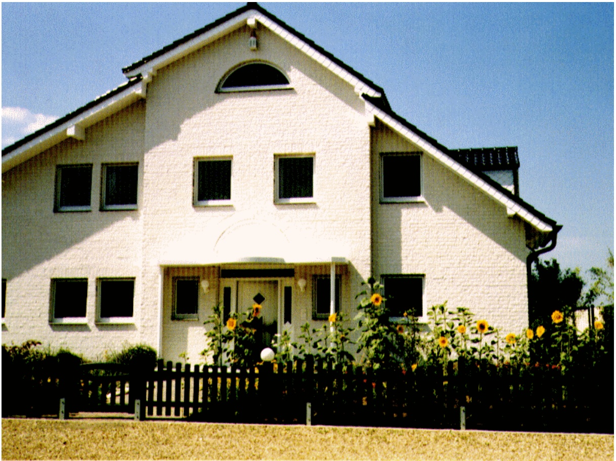
Ansicht des Hauses von Ost-Nordost
