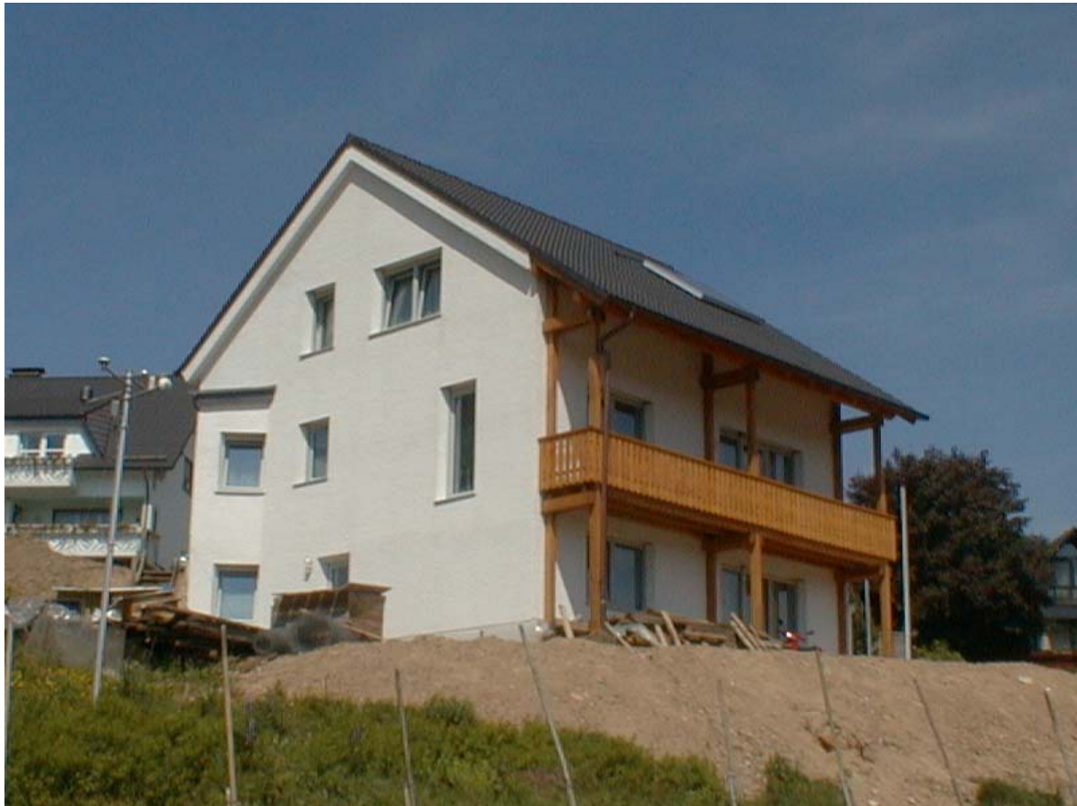
Abbildung 3.4: Ansicht des Objekts Hillmicke von Südwesten.
